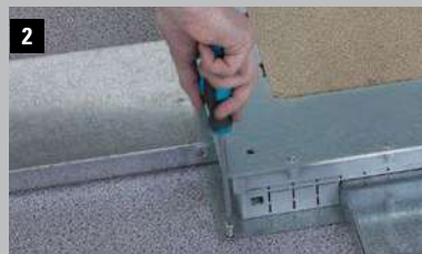
2 Вставить кабель-каналы и привинтить к полу
