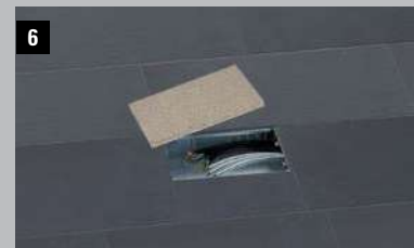
6 Снять защитную заглушку
