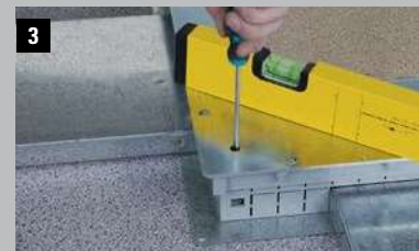
3 Отрегулировать с помощью винтов
